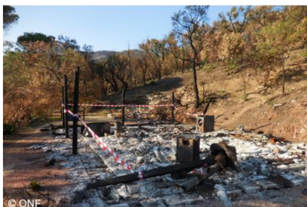
Bâti léger entièrement détruit.
